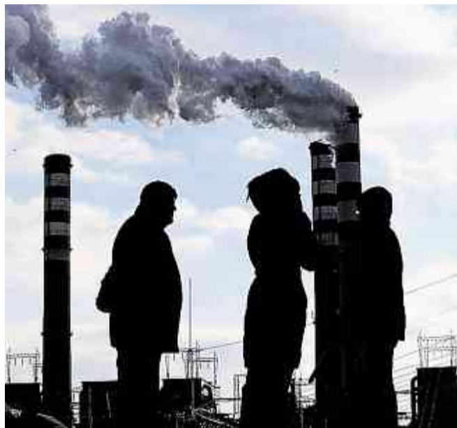
Vor einem Kohlekraftwerk in Polen.
