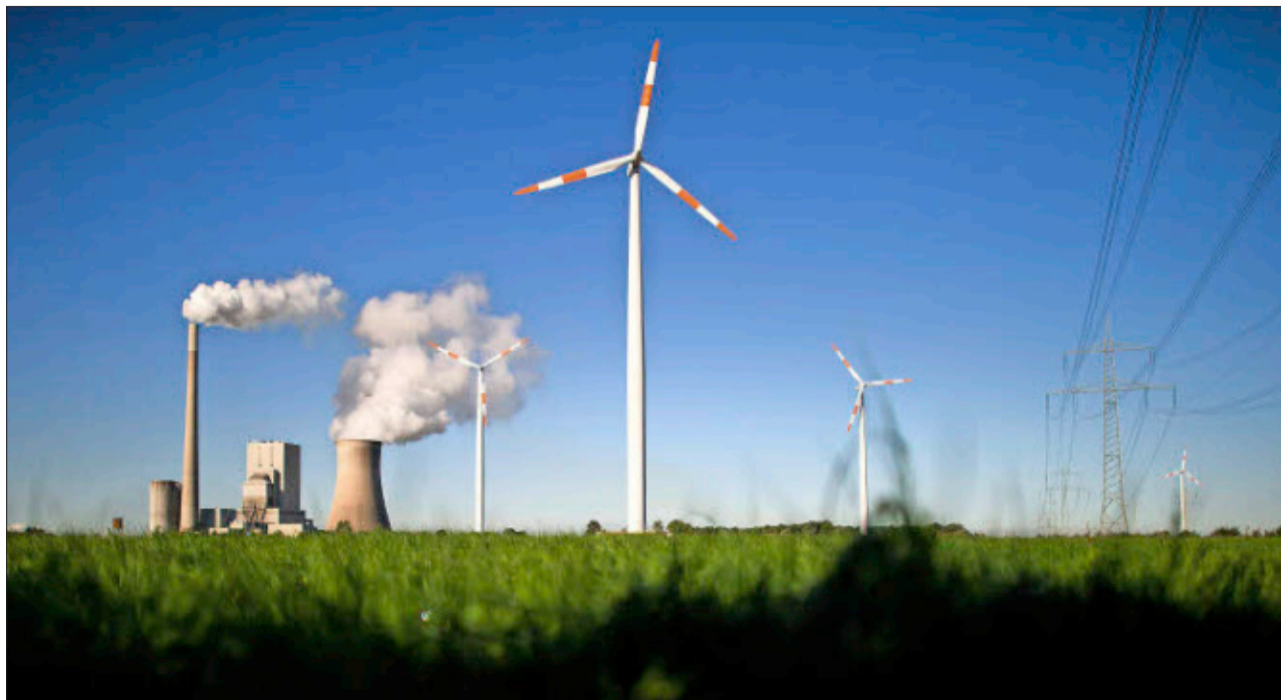
Während den Windrädern die Zukunft gehören soll, dienen bald zahlreiche Kohlemeiler wie dieser in Niedersachsen nur noch als Reserve, um im Notfall die Stromversorgung zu sichern. FOTO: DPA
